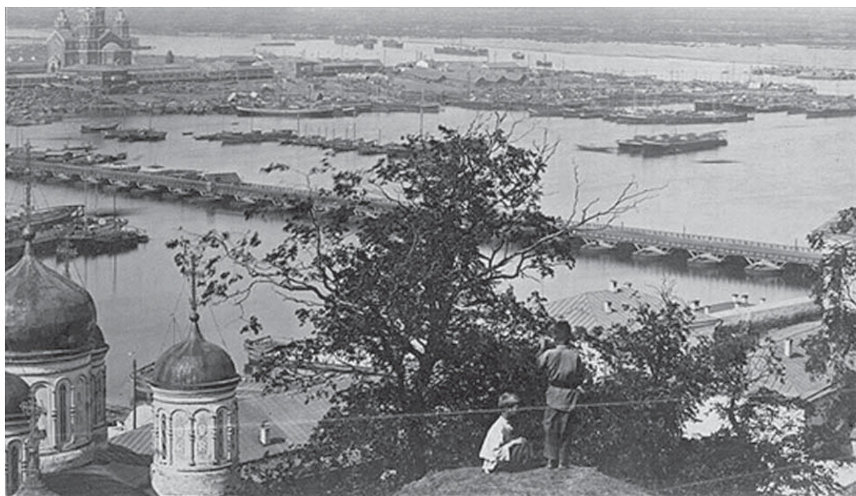
Плашкоутный мост на Оке. Мост из плавучих понтонов с деревянным настилом сверху.
