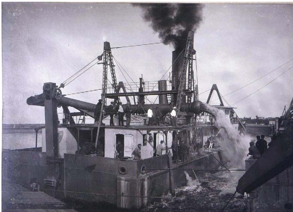
Землесос за работой
