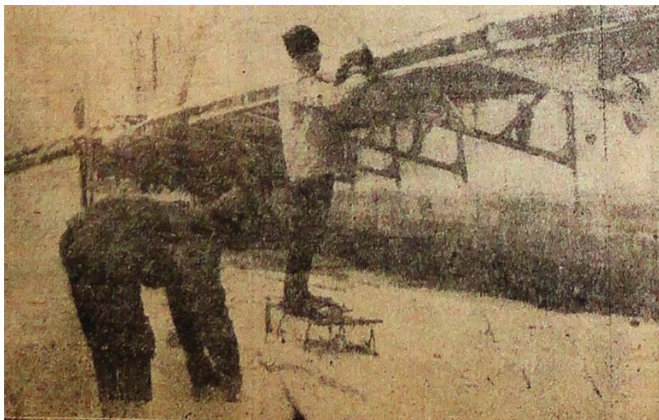
Ремонт привального бруса на пассажирском пароходе
