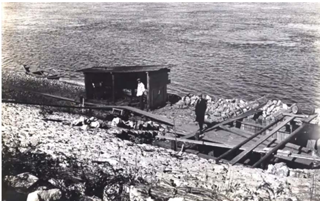
Укрепление дамбы и берега у Покровска (Энгельса)
