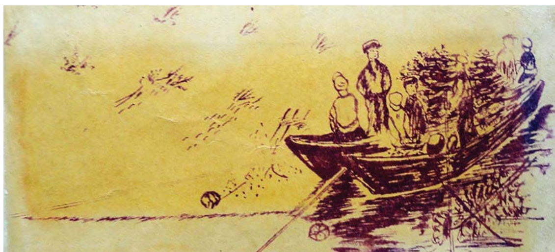
Производство работ на двух спаренных лодках. Опускание куста по шесту
