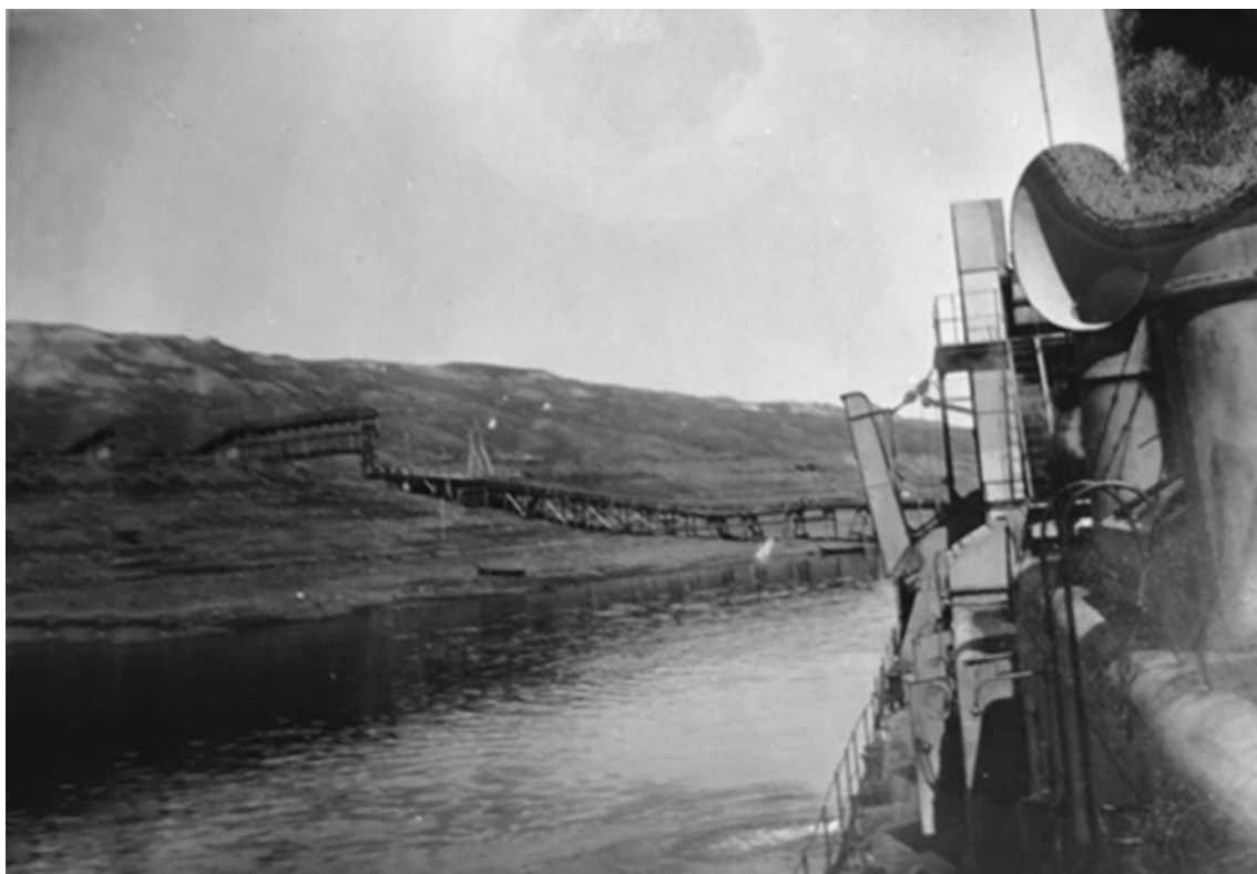
Эстакада угольной площадки г. Ульяновска
