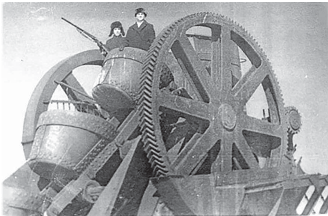
Архивное фото ТАК ВЫГЛЯДЕЛА ЗЕМЛЕЧЕРПАЛКА ПОСЛЕ ВОЙНЫ. В СРЕДНЕЙ ЧАСТИ СУДНА ВОЗВЫШАЛСЯ МЕХАНИЗМ, ПРИВОДЯЩИЙ В ДВИЖЕНИЕ ТРАНСПОРТЁР С КОВШАМИ, КОТОРЫЕ ЧЕРПАЛИ ГРУНТ. ФОТО, ОРИЕНТИРОВОЧНО, 60 –х ГОДОВ.
