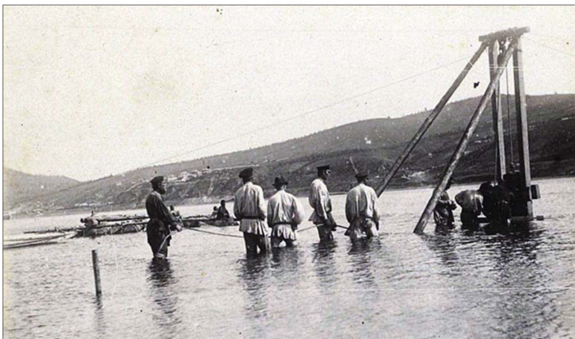
Забивка свай водомерных постов на гидрометрической станции
