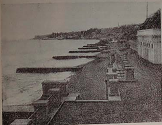
Рис. 3. Морской берег, укрепленный бунами.
